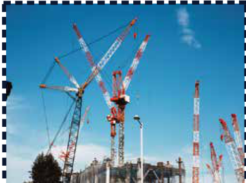
クレーン作業現場
