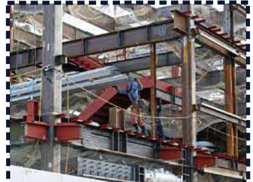
高所作業現場
