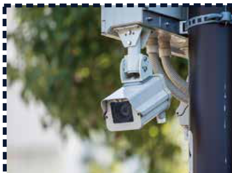
防犯カメラ設置工事
