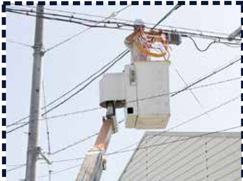
電気や電話・LANの配線設置工事
